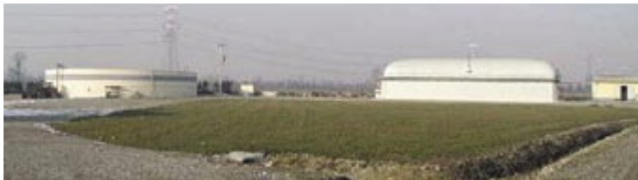
Impianto di biogas
