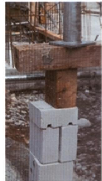
Soluzione improvvisata nell'uso di puntelli troppo corti. Il "basamento" viene sollecitato in modo eccentrico ed è difficilmente in grado di sopportare le vibrazioni generate dall'operazione di getto del calcestruzzo.
