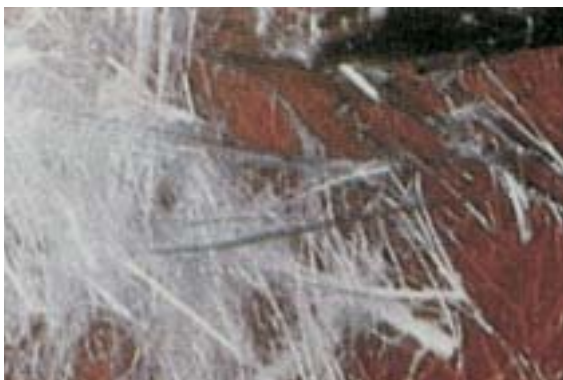
Fibre di amianto.
