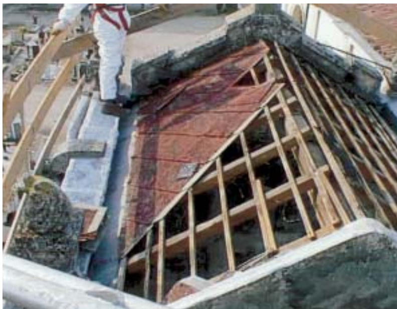
FOTO 9 – Intervento di rimozione di piastrelle in cemento amianto da cappella funeraria. Il manto di copertura rimanente appare colorato in rosso in quanto trattato con incapsulante.
