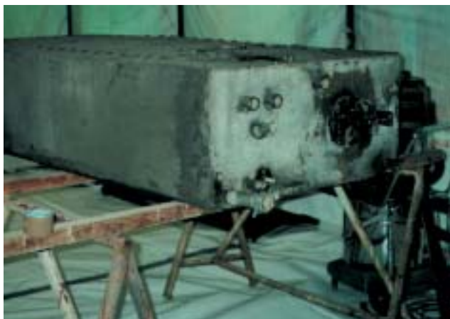
Serbatoi coibentati con tessuto d'amianto.
