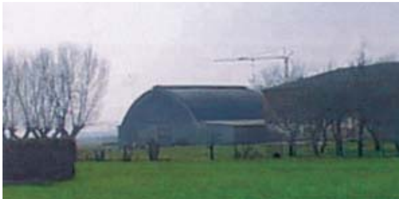
FOTO 2 – Capannone agricolo con copertura di tipo curvo ed inclinazione marcata.
