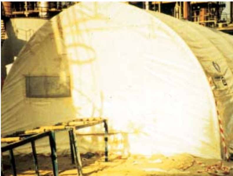
Tunnel per scoibentazione tubazione.
