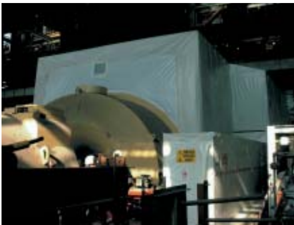
Confinamento di impianto industriale. Si noti sulla destra il tunnel allestito come unità di decontaminazione.
