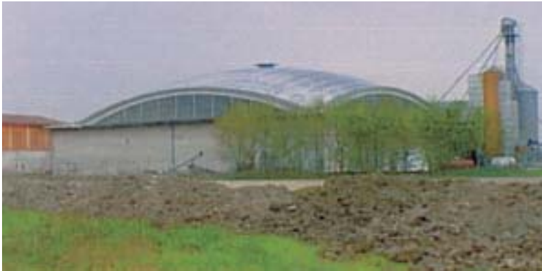
FOTO 1 – Capannone industriale con ampia copertura di tipo curvo a modesta inclinazione.
