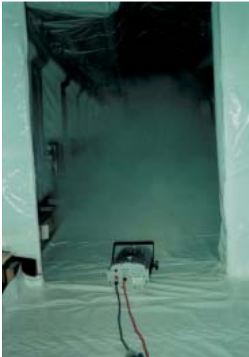
Macchina del fumo per prova di tenuta con fumogeni.
