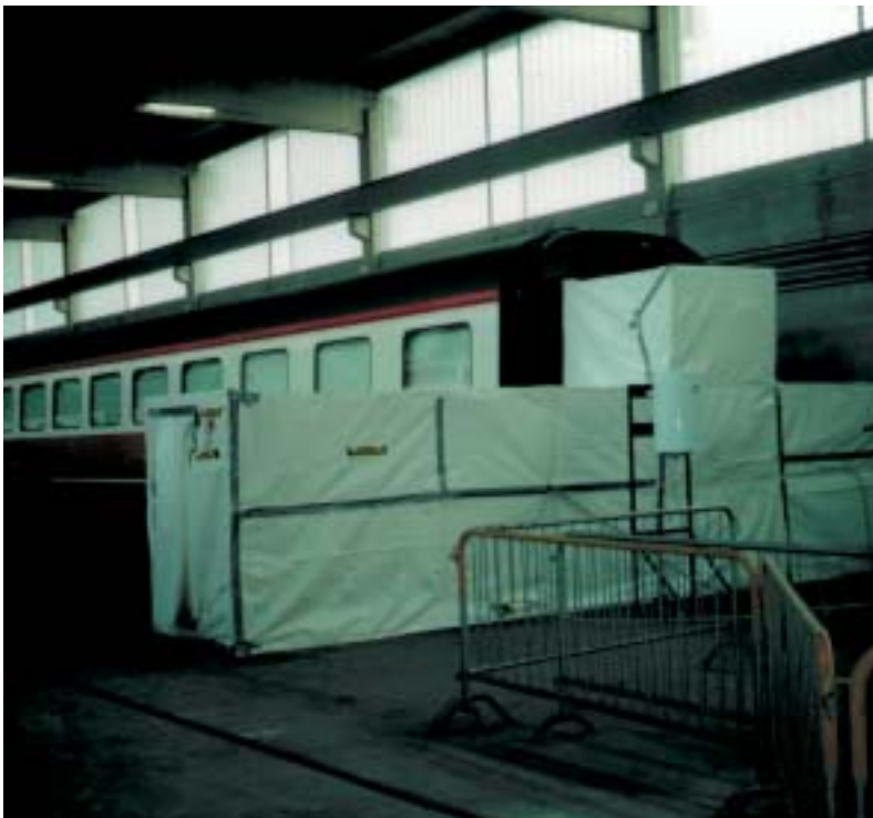
UDP realizzata in polietilene per l'accesso a zona confinata realizzata su carrozza ferroviaria.
