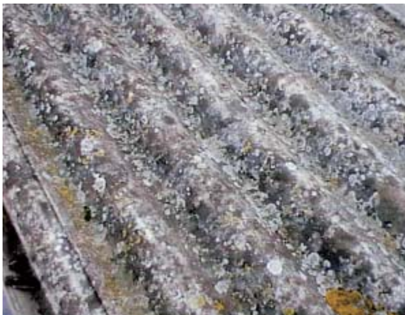
FOTO 5 – Lastra in eternit datata di oltre trent'anni in buono stato di conservazione. Evidente la presenza di materiale organico quali licheni e muffe. Su di un simile materiale, per un eventuale bonifica con rivestimento incapsulante si renderebbe necessario l'intervento di lavaggio.
