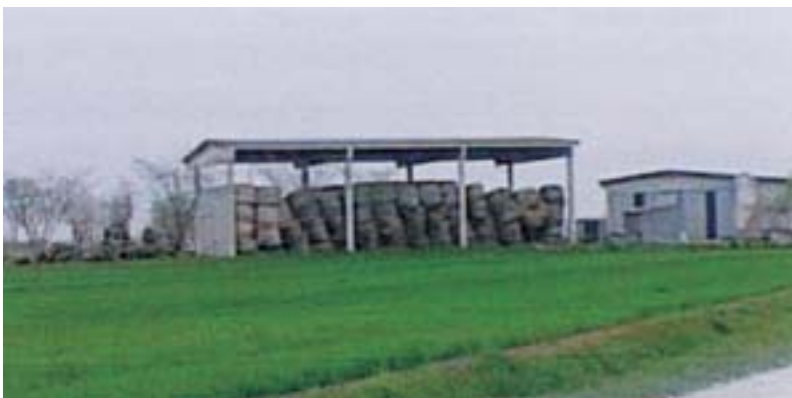
FOTO 3 – Tettoia agricola a doppia falda a modesta pendenza.
