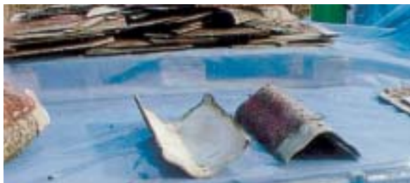
FOTO 7 Tegolature di colmo in cemento amianto. Il rosso in evidenza si riferisce al prodotto incapsulante appena usato.
