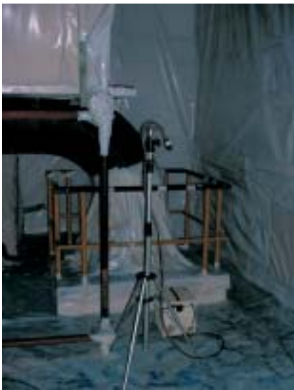
Campionamento dell'aria all'interno di un'area confinata con filtri in polycarbonato per l'analisi in SEM al fine di rilasciare il certificato di restituibilità.
