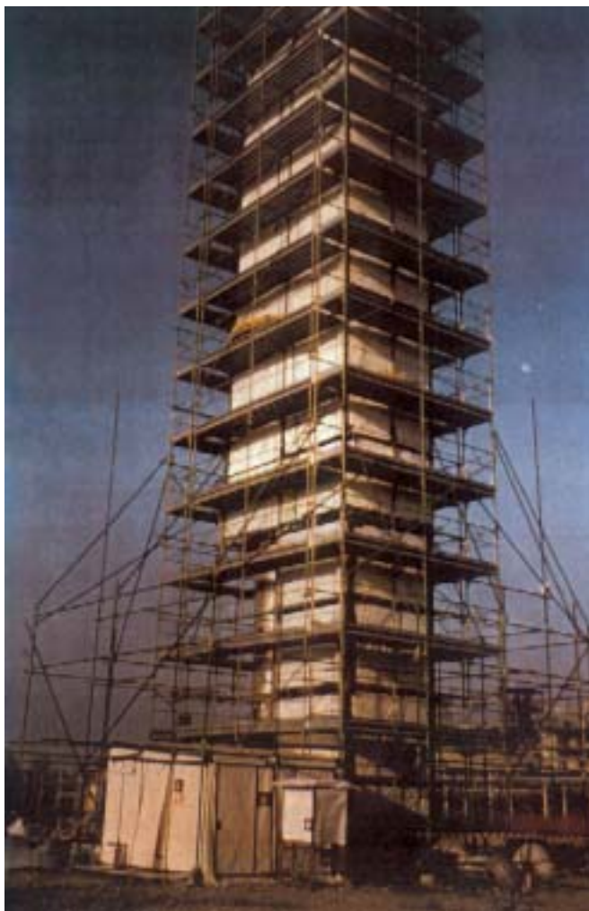
Impalcatura di area confinata.
