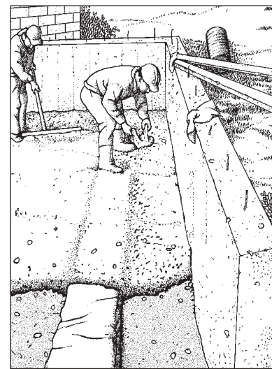
Fig.16 Getto della soletta controterra
