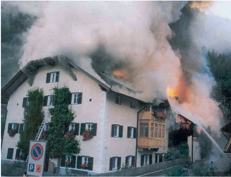
Fig. 17 - L'incendio si estende dal fienile al caseggiato
