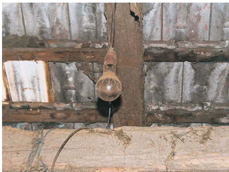
Fig. 10 - Lampade non protette che presentano superfici molto calde non possono essere utilizzate in locali polverosi
