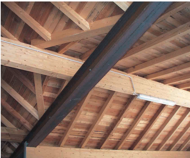
Fig. 18 - L'acciaio ha caratteristiche di resistenza al fuoco peggiori del legno
