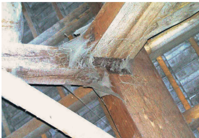
Fig. 13 e 14 - Ragnatele possono provocare piccole esplosioni che innescano l'incendio
