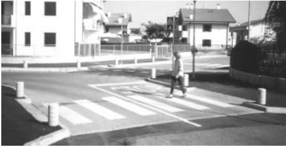
Esempio di moderazione del traffico ottenuto con allargamento dei marciapiedi, restringimento della strada e cambio della pavimentazione
