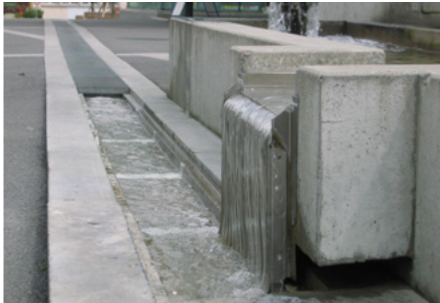
Figura 24: Canale di una fontana
