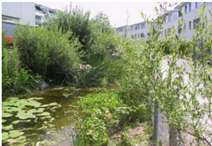
Figura 18: Vasca di ritenzione in un quartiere
