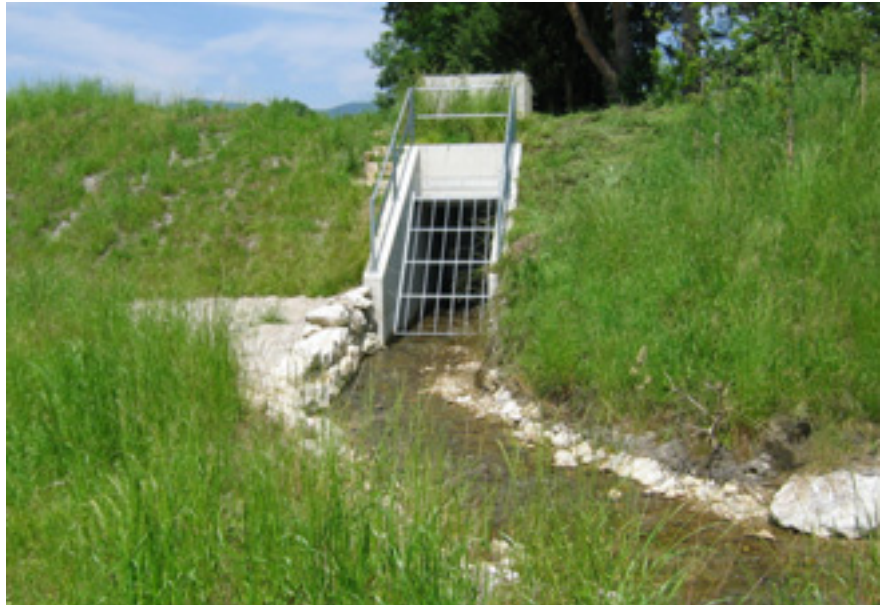
Figura 25: Acquedotto con grata di sicurezza
